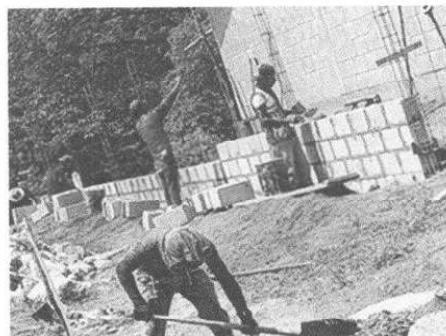
Foto 4: Se observa la parte donde esta la casa comunal y al a lado del módulo 1, se necesita muro perimetral, esta en construcción.
